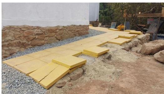
*Piso externo; preparação para drenagem e baldrame reforçado.*
